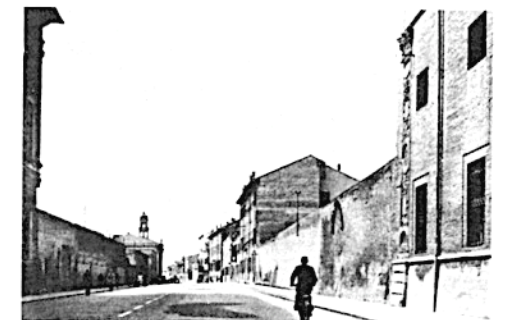
Ferrara, via dei Prioni, dorsale dell'addizione, congiunge la piazza nuova al sagrato di S. Benedetto (campanile in fondo).
