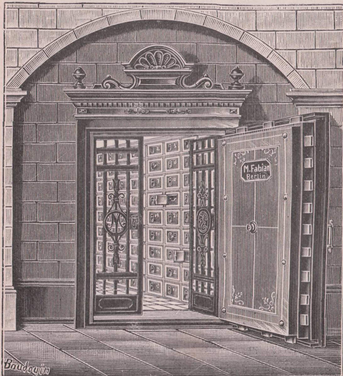
Sicherheits-Stahlkammer einer großen Bank (geöffnet).
