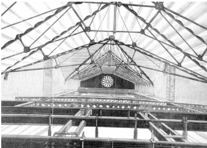
18. Aristide Leonori, travi Polonceau nel sottotetto della nuova abside, da C. Barucci, Virginio Vespignani , Roma 2006.
