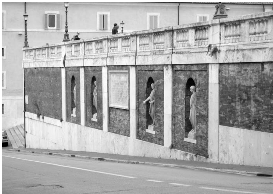
5. Virginio Vespignani, muro di sostegno della piazza.
