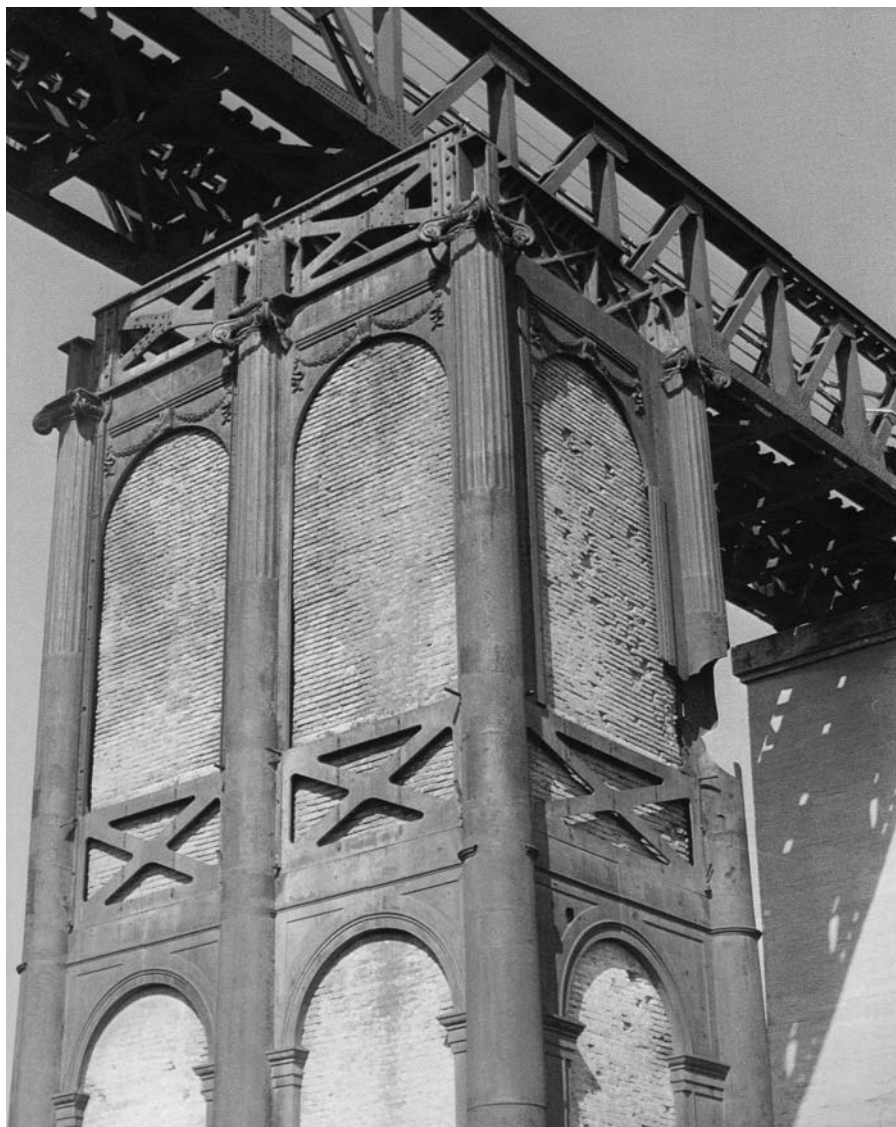
12. Viadotto ferroviario di Velletri.
