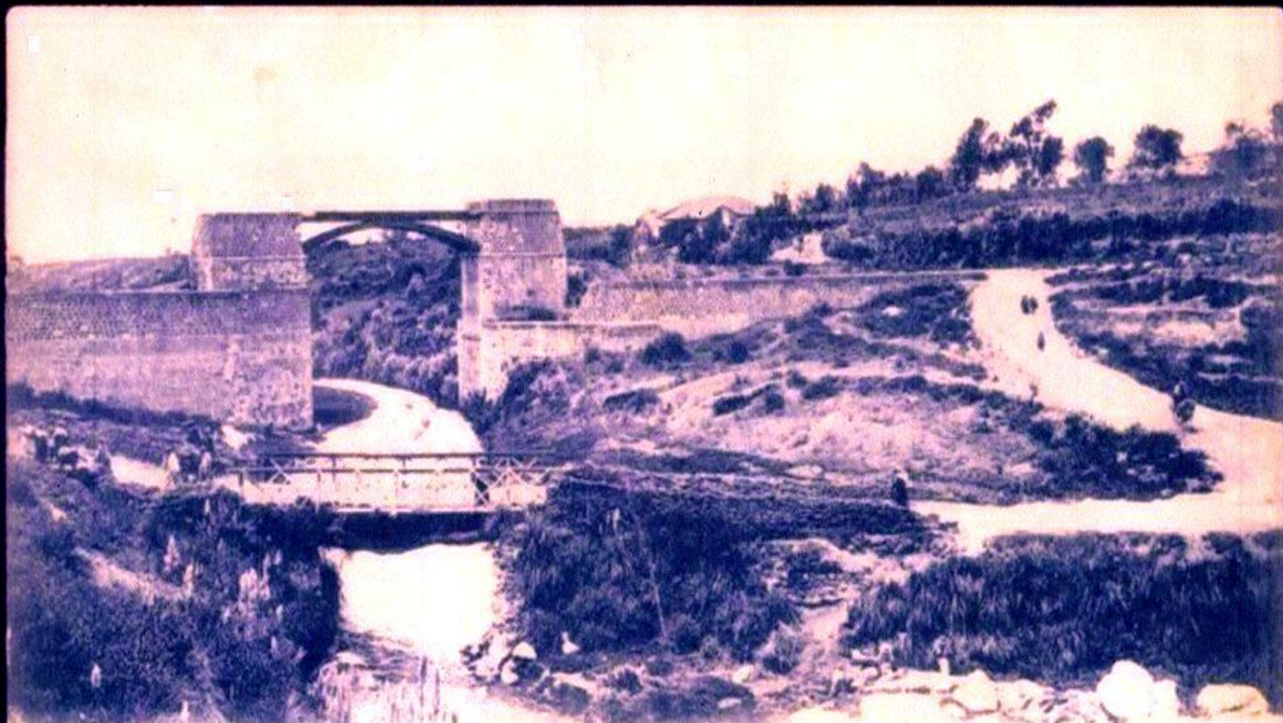
ARCHIVO PAREDEZ BAUTISTA.-LATACUNGA-ECUADOR. PUENTE CUTUCHI.-TARJETA POSTAL DEL AÑO 1.905, TRABAJADA POR IMPRENTA MERCANTIL DE GUAYAQUIL CON SUS EDITORES MARIN Y MARTINEZ. CABE SEÑALAR QUE EL CITADO PUENTE SE MANTUVO INCONCLUSO HASTA EL 22 DE AGOSTO DE 1.920, CUANDO FUE AL FIN INAUGURADO GRACIAS AL ENTUSIASMO DEL GOBERNADOR DE LEON RAFAEL ARCOS Y EL EMPEÑO DEL PRESIDENTE DE ECUADOR ALFREDO BAQUERIZO MORENO. LA OBRA ESTUVO DIRIGIDA POR EL ITALIANO HUGO RAMPANI, EL CONTRATISTA FUE EL ARQUITECTO MARIANO FREIRE DE ANDRADE...
