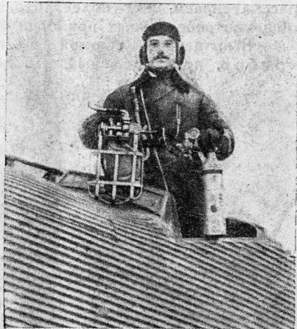
Рис. 100. Прибор Дрегера для больших высот, примененный при установлении мирового рекорда высоты
