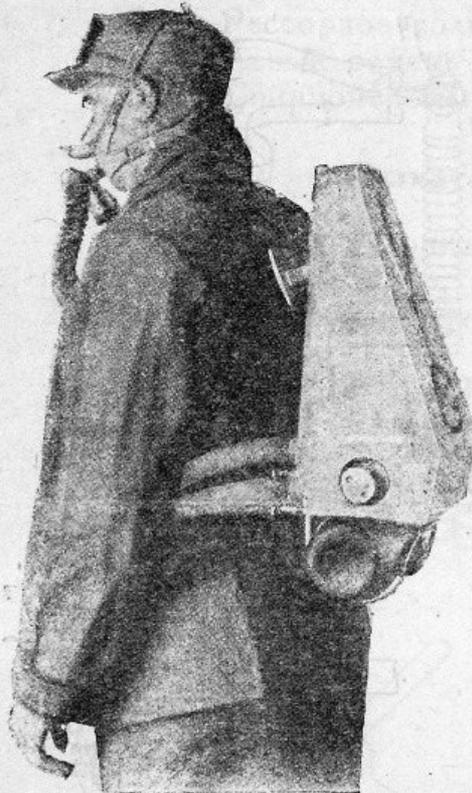
Рис. 83. Внешний вид аппарата Мак-Каа.
