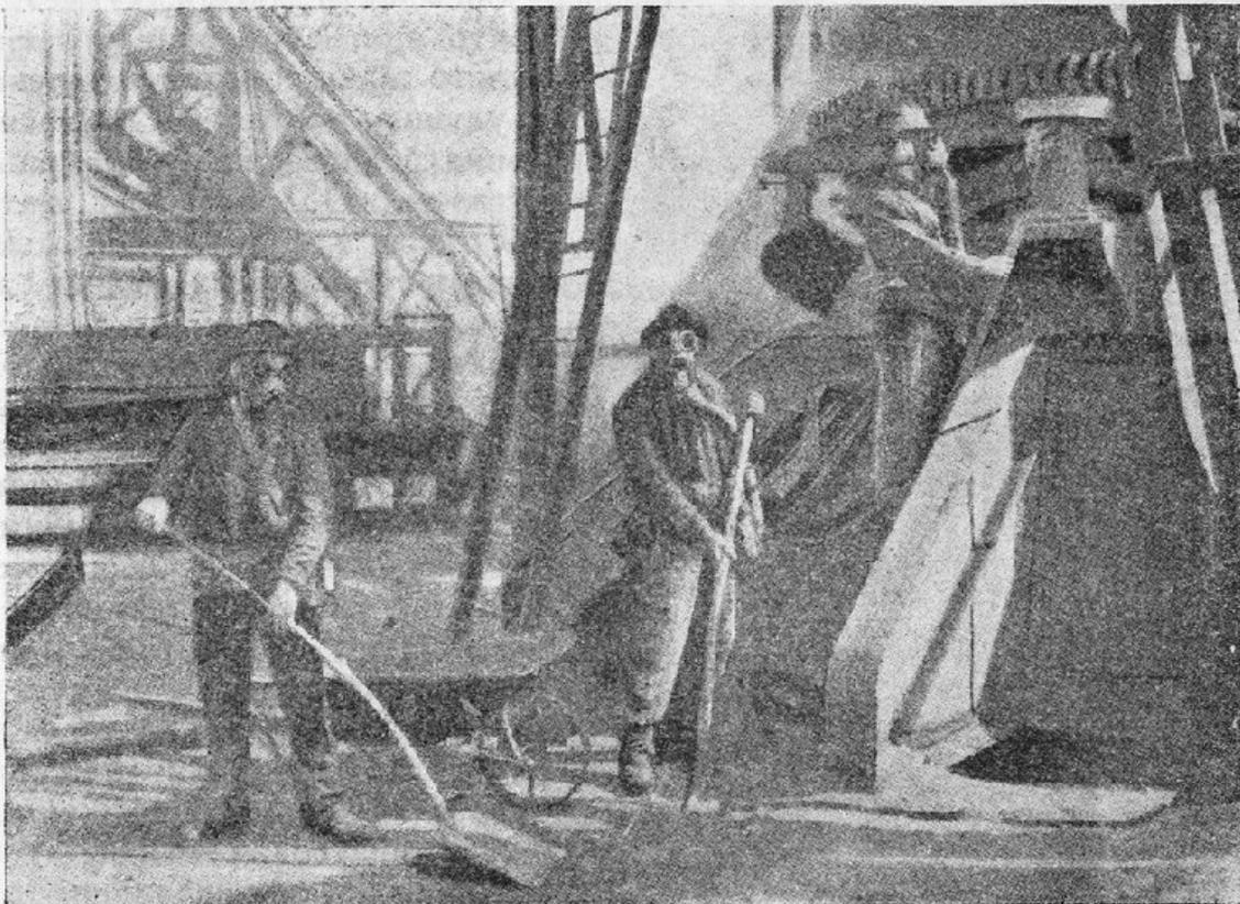
Рис. 61. Уборочные и ремонтные работы на доменной печи в газовых масках Дегеа СО.
