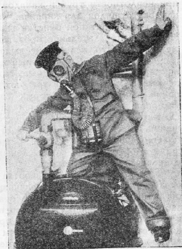
Рис. 59. Газовая маска Дегеа СО у рабочих—газовиков. Запирание крана газометра при неисправности труб.
