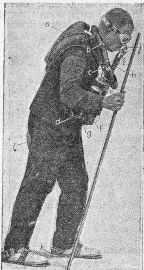
Рис. 107. Подводно-спасательный прибор Дрегера мод., 1926 г.
