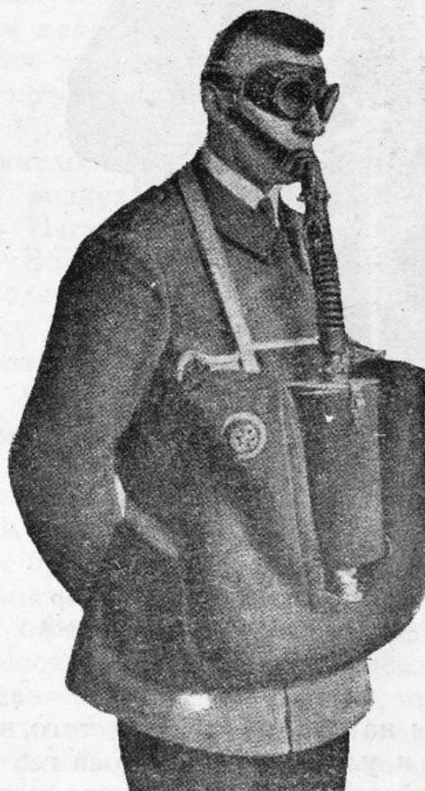
Рис. 126. Проксиленовый прибор Аудос. Нагрудный тип.
