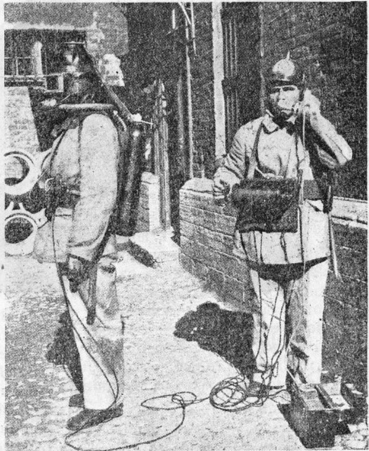
Рис. 73. Дыхательный прибор инж. М. Н. Вассерман в действии. (Лен. пож. к-да).
