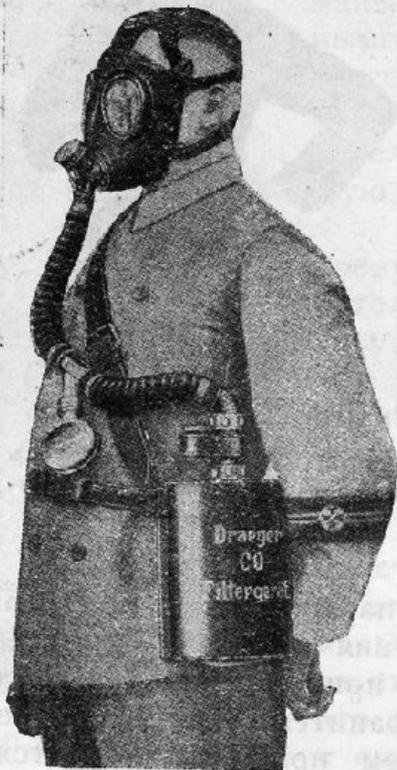
Рис. 52. Газовая маска СО Дрегера.
