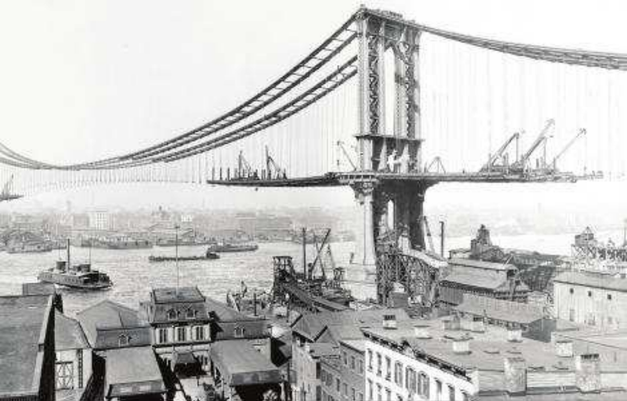
Le pont de Manhattan, le 23 mars 1909. Franchissant l'East-River, il relie l'île de Manhattan au quartier de Brooklyn. Il offre sur deux niveaux sept voies de circulation automobile, quatre voies ferrées, une voie piétonne et une voie cyclable.
