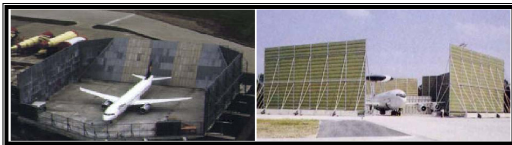
Figura 7.1.2. Encierros con barreras acústicas en operaciones run-up . Fuente: [10]
