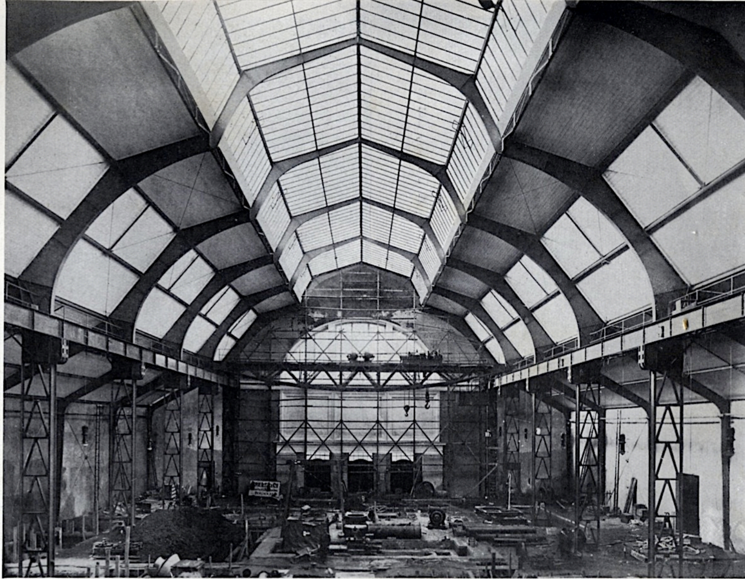
Peter Behrens: Deutsche Kraftmaschinenhalle auf der Weltausstellung 1910, Brüssel
