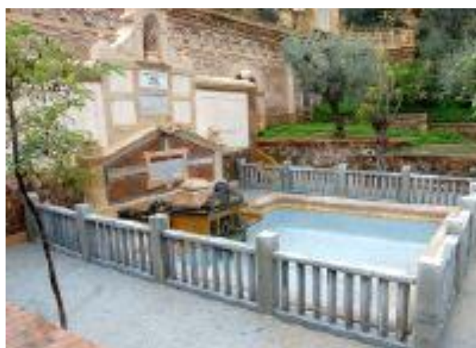
Foto 2. La fuente tras la segunda restauración en 2006.
