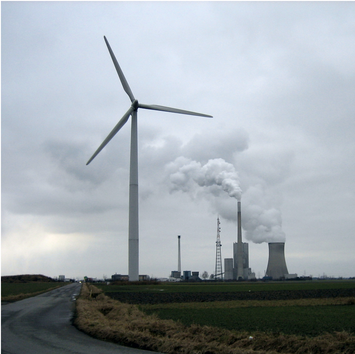
Abb. 111 Industrielandschaften können aus unterschiedlichen Gründen aufgenommen werden. Dieses Bild ist aus gesellschaftlicher Sicht recht interessant - es zeigt erneuerbare Energieanlagen neben herkömmlichen. Damit drückt es einen gewissen Wandel in der Gesellschaft aus.
