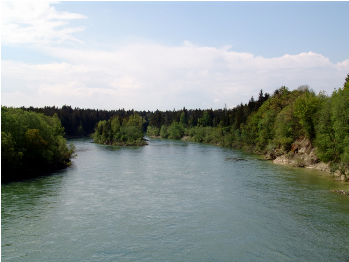
Abb. 19 Lech unterhalb des Stauwehrs 18
